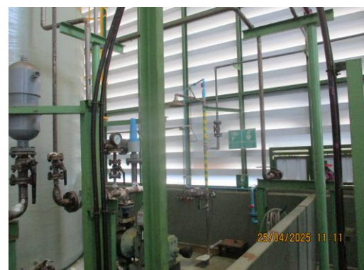
รูปที่ 21 ฝักบัวและที่ล้างตาฉุกเฉิน
