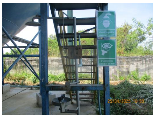
รูปที่ 21 ฝักบัวและที่ล้างตาฉุกเฉิน
